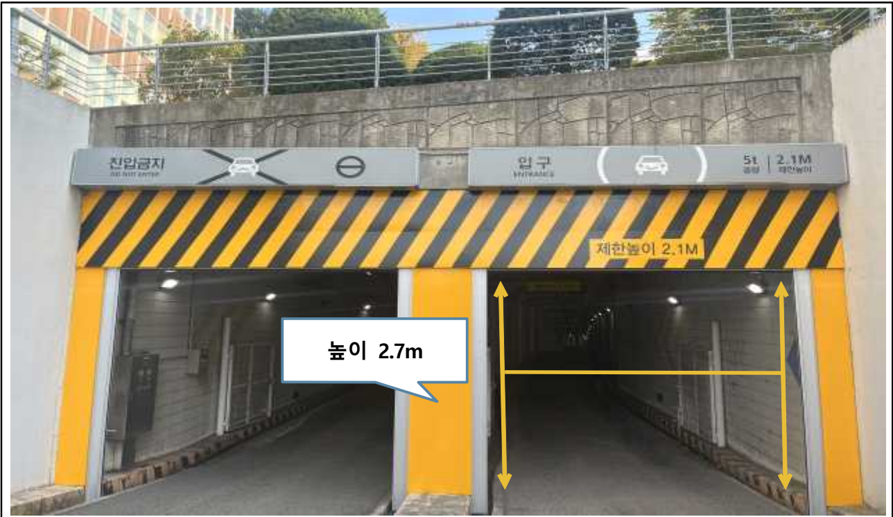
서문 주차장 입구 ( *제한높이 2.1m로 기재 표기 되어 있으나, 실제높이 2.7m )
