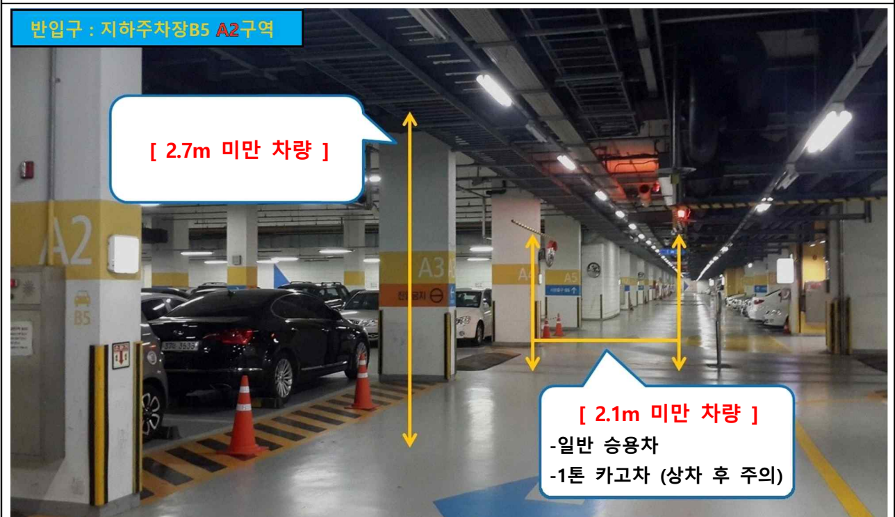
지하 5층 반입구 이동로 높이
