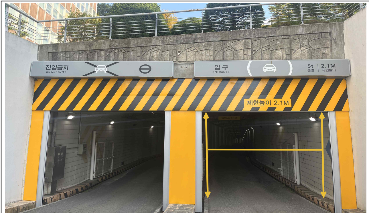
서문 주차장 입구, 제한높이 2.1m
